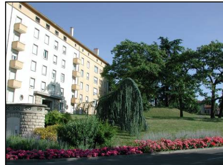
Accompagnement végétal des espaces libres du quartier de Bioux
