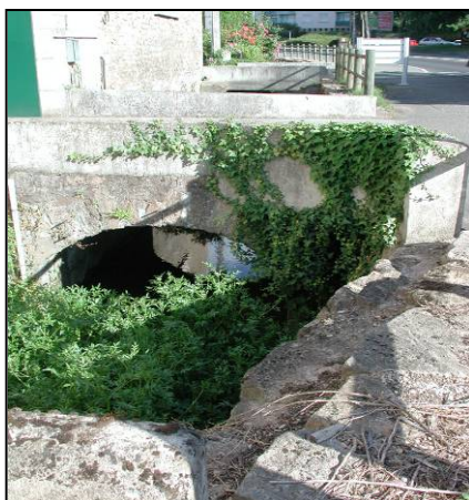
Ouvrage de franchissement du Bioux dans le quartier Saint Clément
