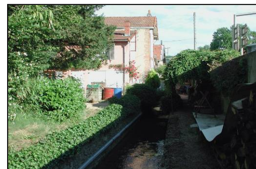
Le Bioux canalisé dans le quartier de Saint Clément
